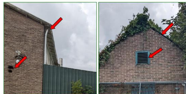
De openingen achter de boedelen en regenpijpen (woning) en dakpannen en rooster (schuur) (rode pijlen) van de bebouwing geven mogelijk toegang tot voor vleermuizen geschikte achterliggende ruimtes.
